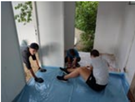
Bevor der neue Boden rein kann, muss dieser erst abgedichtet werden
