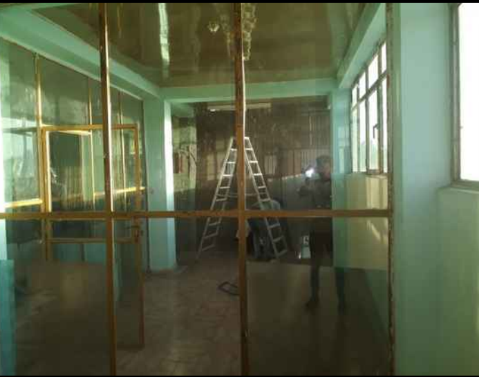
Das neue Büro im Aufbau
