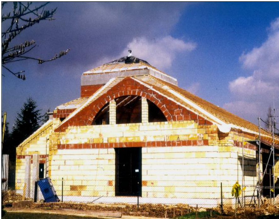
Rohbau mit Pfarrzimmer (unten) und „Raum der Stille“ (1. Stock)
